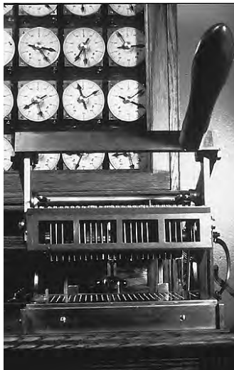
Bild 6/26: Der Lochkartenleser konnte durch elektrischen Kurzschluss die Informationen lesen und steuerte die Zählräder an.
